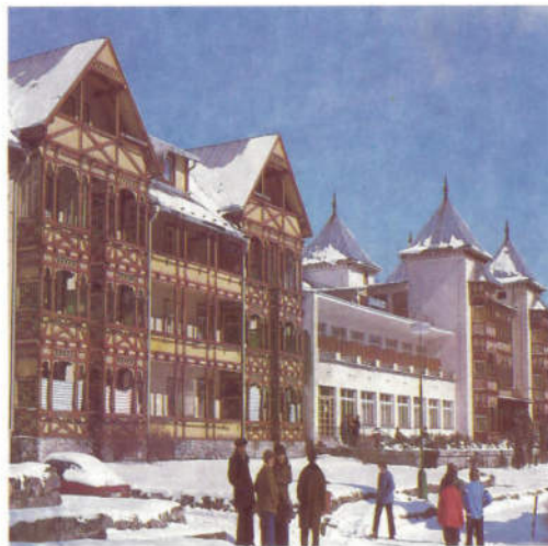
31 Liečebný dom Branisko, Nový Smokovec 1000 m I. Urbanovič
