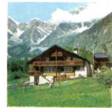
Casa in legno Caratteristica architettura di Macugnaga
